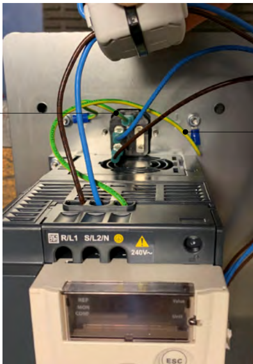
Billede 1: Frekvensomformer ATV12, forsyningsterminaler ind.
